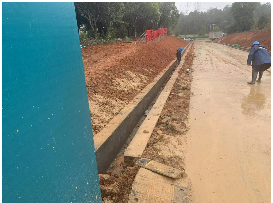
进站道路区排水沟
