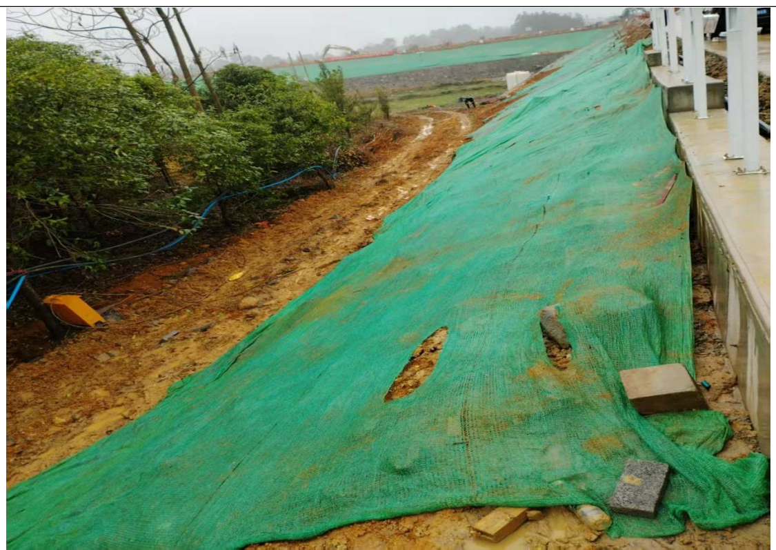
变电站区临时苫盖
