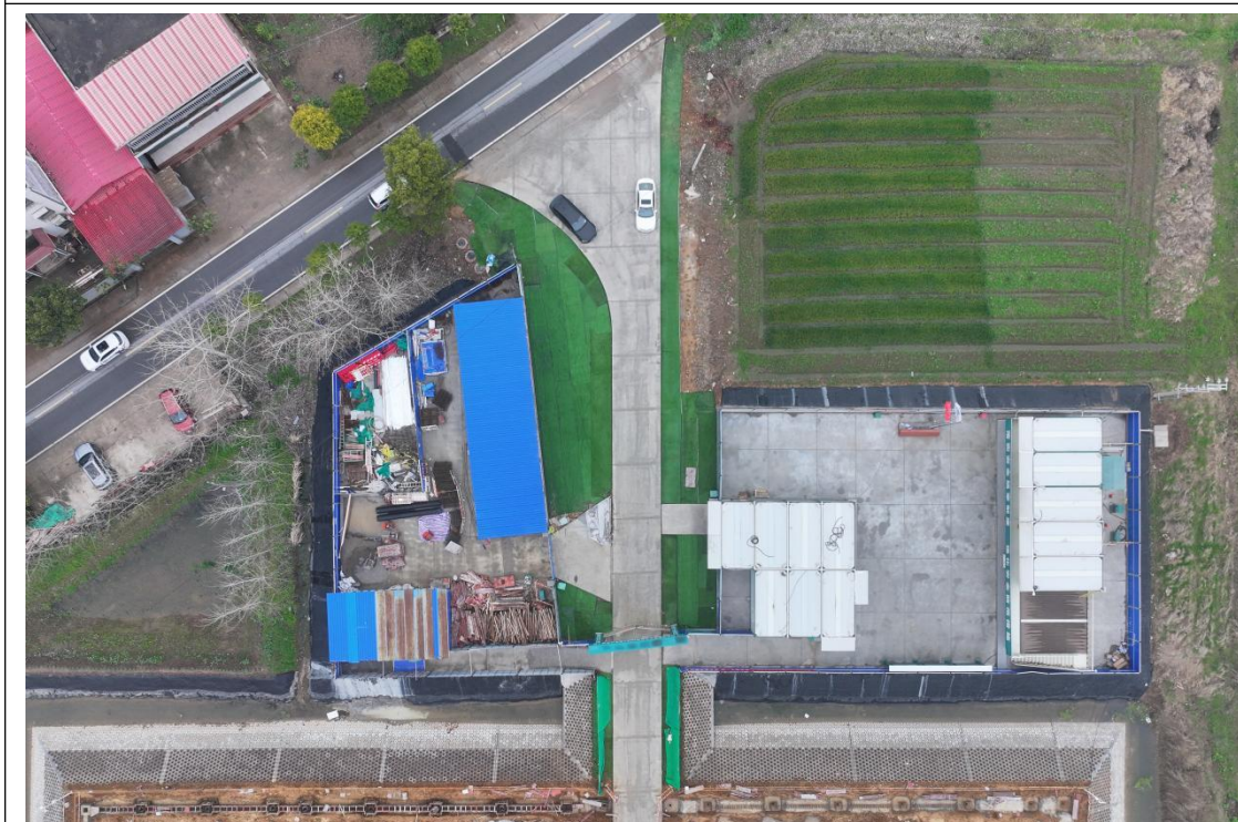
进站道路区临时苫盖
