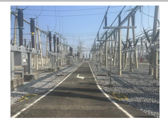
站内碎石铺平及道路硬化
