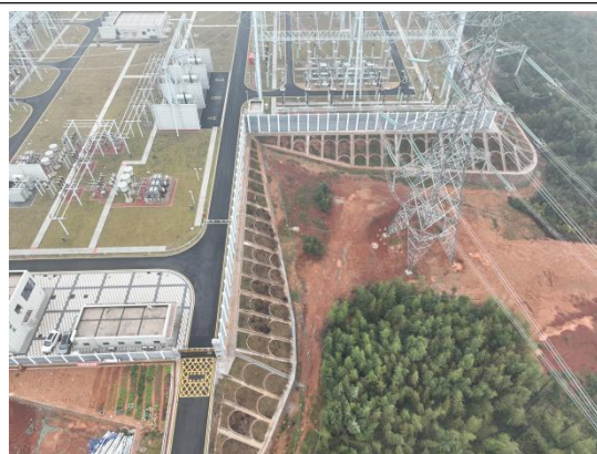
站外构格植草护坡
