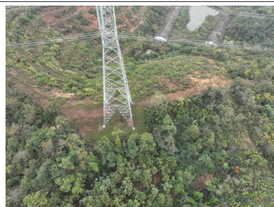
ZA7 塔基及施工道路
