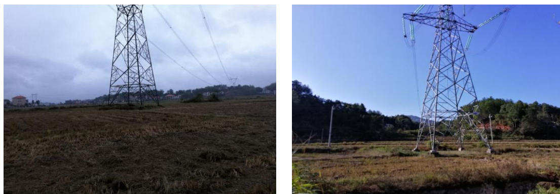
500kV 民鹤 II 线沿线农业生态环境 图 6-3 农业生态恢复情况实景照片
