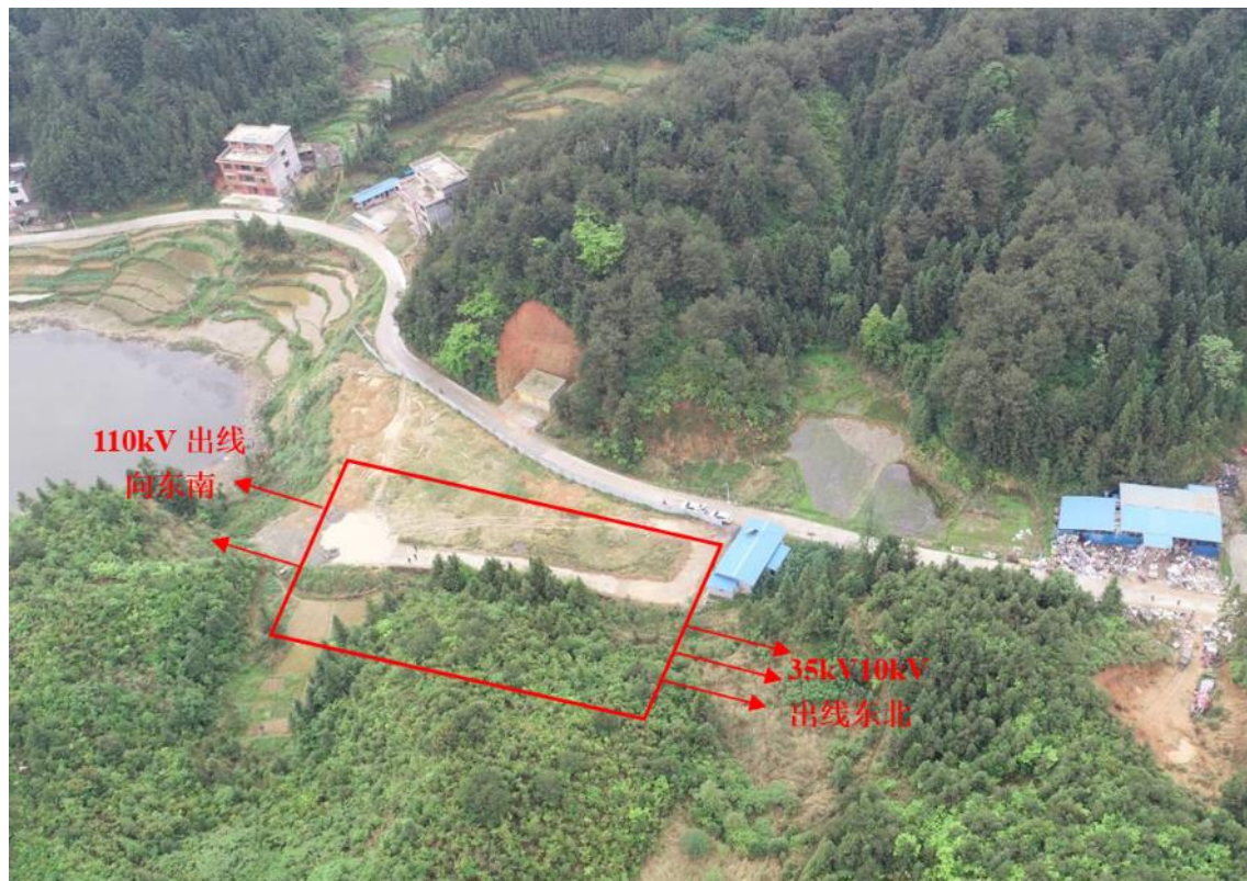
司门前 110kV 变电站俯视图
